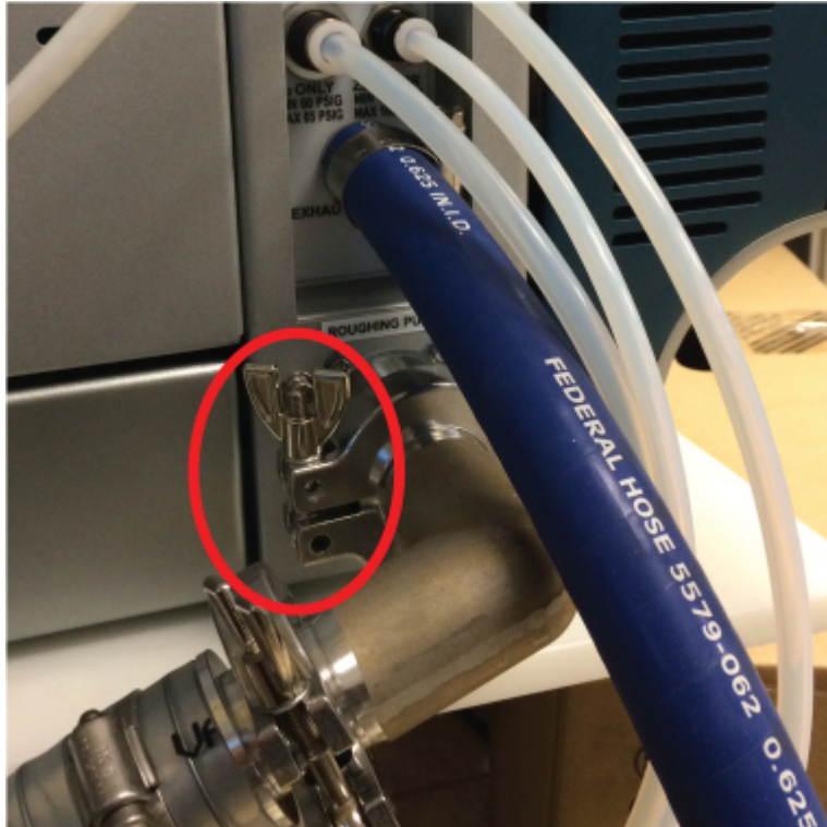
그림 5-15 올바르게 설치된 클램프
